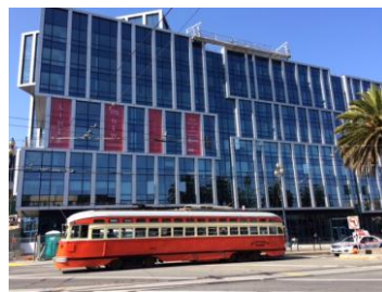
研修施設が入るマンション (※2014年から)
